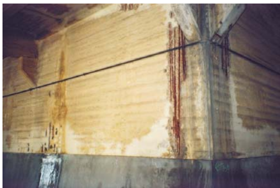
Lateral exterior de parte inferior de tanque
