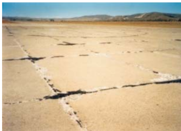
Calle de carreteo del aeropuerto de Bariloche - Provincia de Río Negro
