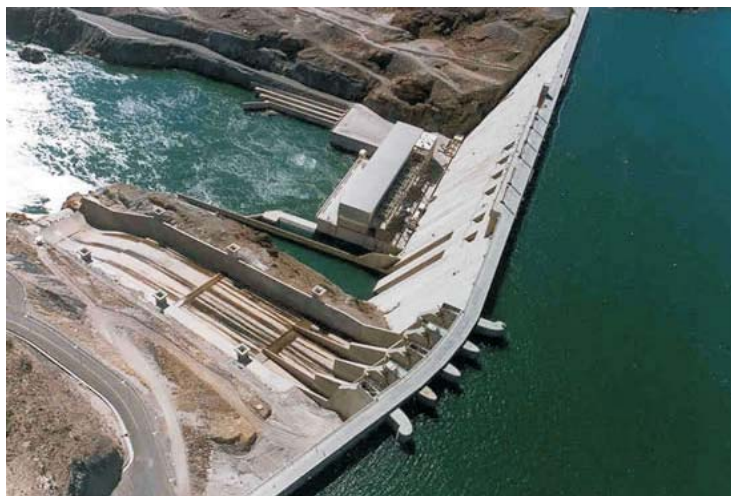
Vista aérea de Piedra del Aguila
