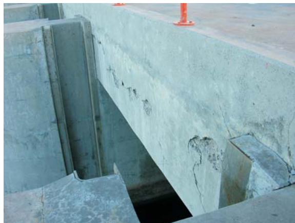
Placa de la Obra de Toma - Vista parcial.
