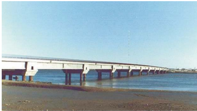
Puente sobre el Río Grande - Territorio de Tierra del Fuego
