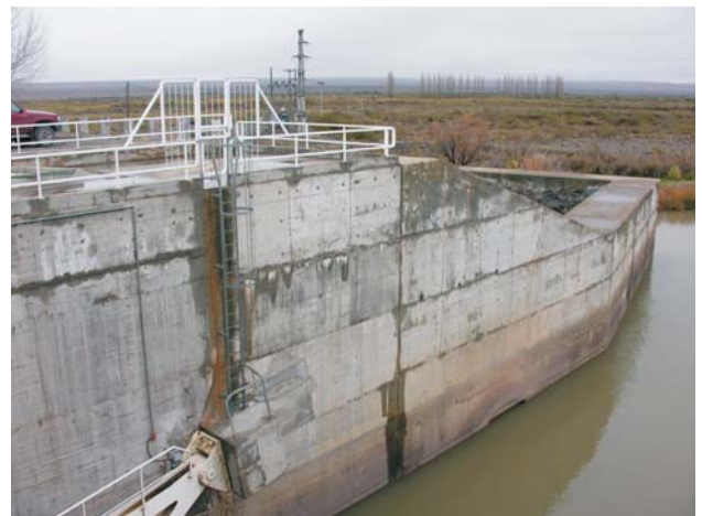
Muro de Vertedero Portezuelo Grande
