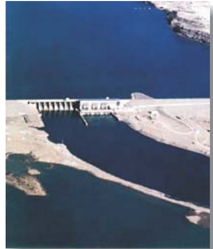
Vista aérea de la presa compensadora el Chocon de 3400 m de longitud y una altura máxima de 26 m
