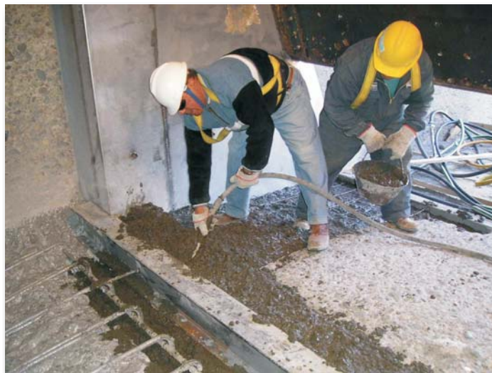
Reparación con hormigón
