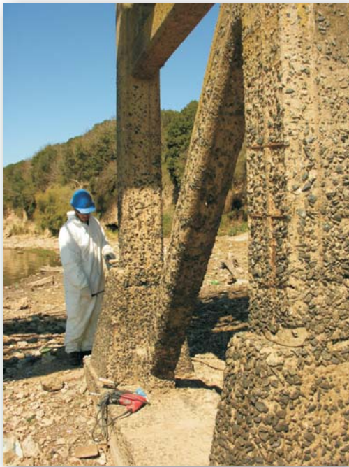
Pila erosionada
