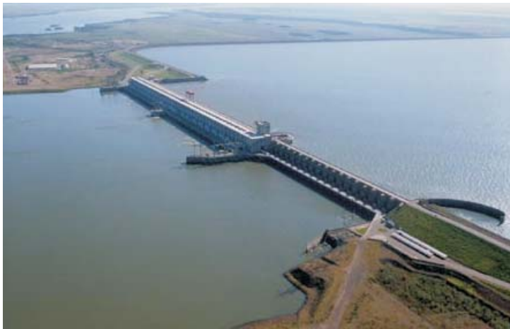
Vista aérea de la presa principal
