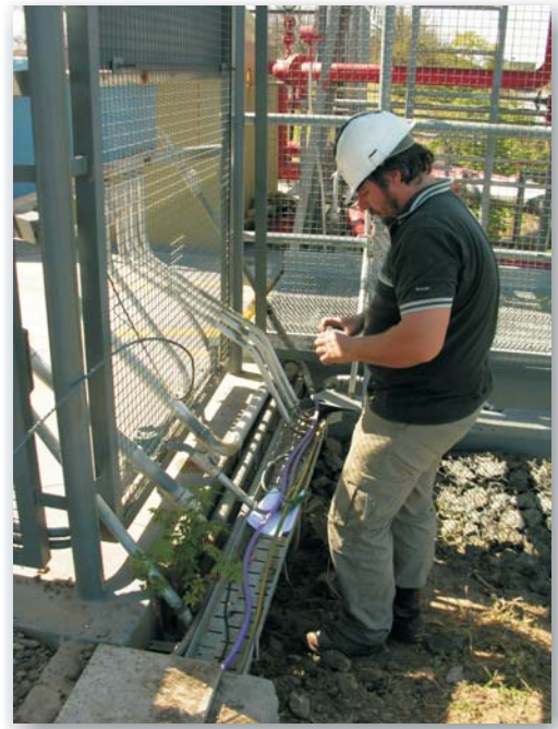
Verificación - Puesta a tierra
